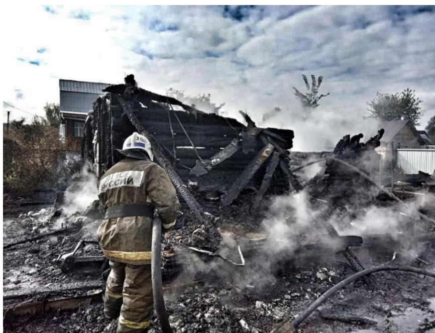
Рис. 1. Потеря устойчивости при пожаре здания
